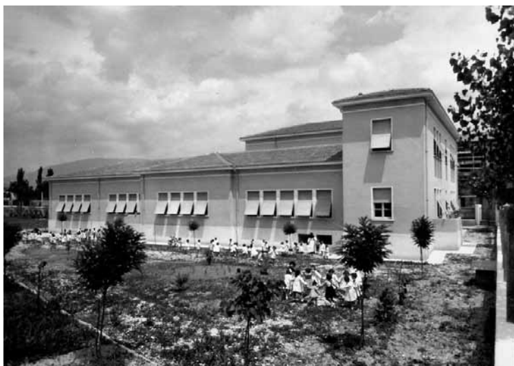
La nuova sede dell'asilo in Viale Guglielmo Marconi, post 1955. Archivio Asilo infantile G. Garibaldi, Foligno, Materiale fotografico
